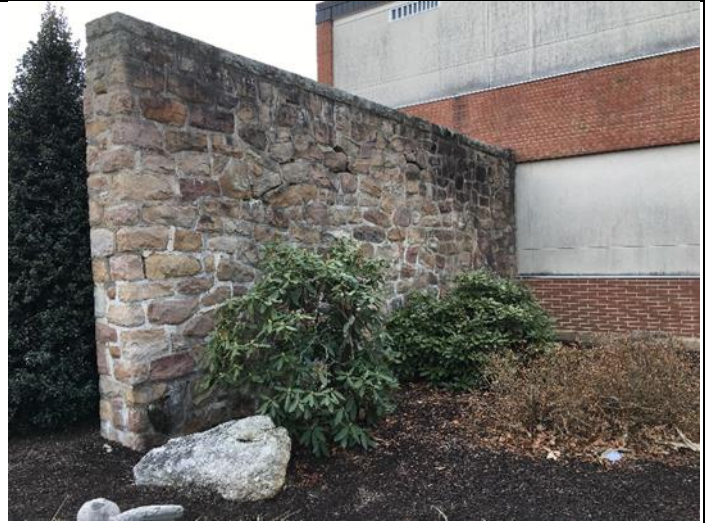
Wall Adjoining HS
